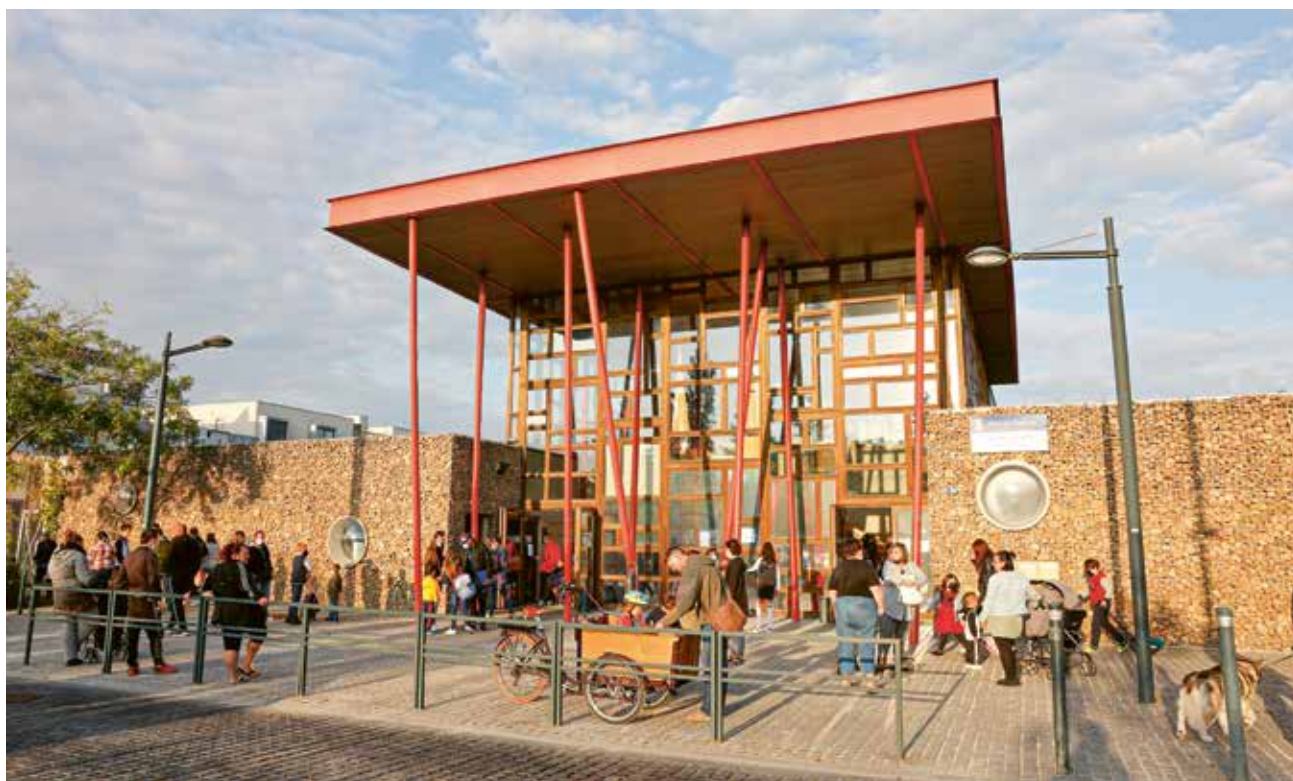
En 2023, l'école Henri-IV a connu une transformation majeure avec le changement de toutes les portes donnant sur la cour élémentaire, la rénovation des pelouses, le changement du sol du réfectoire maternelle et l'installation de la bibliothèque élémentaire.
