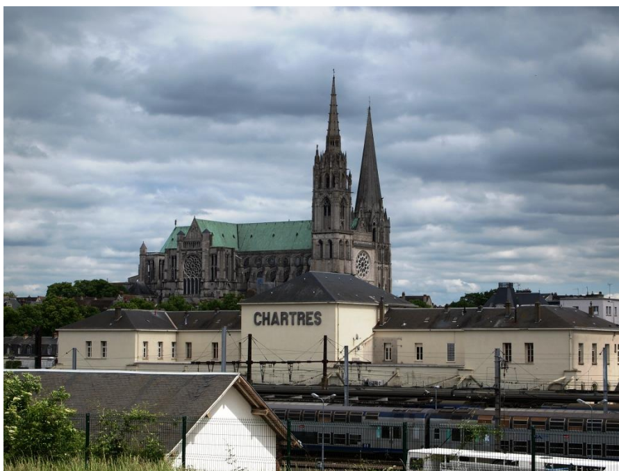
Vue depuis la rue du Chemin de fer
