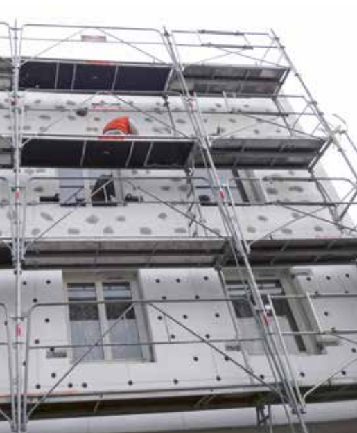
Pendant les travaux
