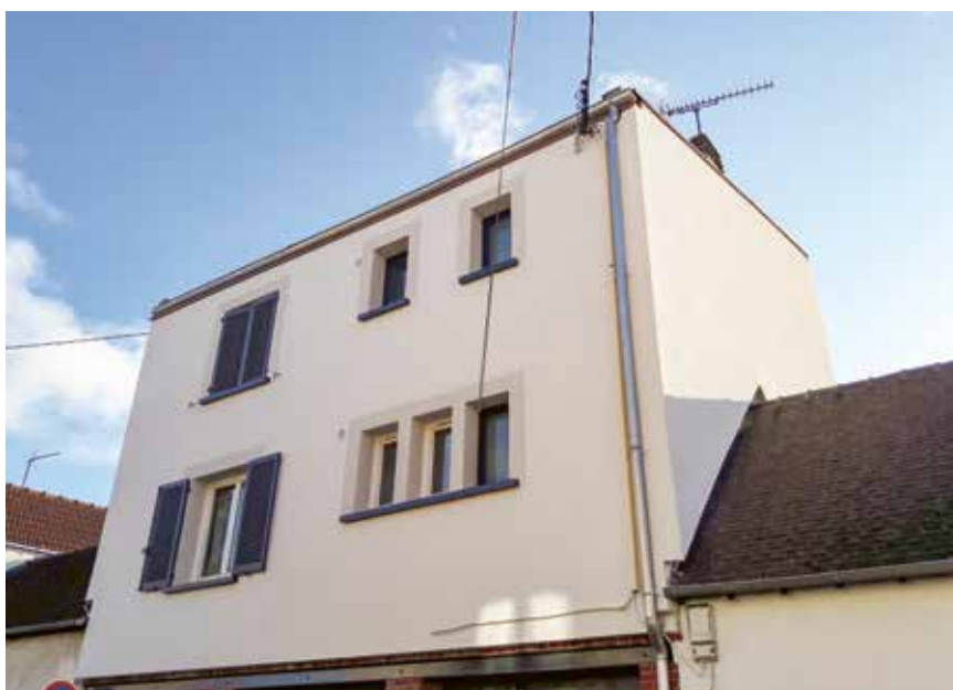
Après les travaux
