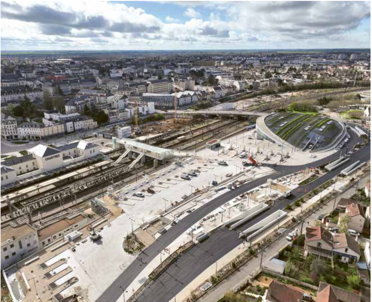
Le Pôle gare et sa plateforme multimodale, sous laquelle a été créé le parking Gare-Colisée. Un exemple d'aménagement multi-usages et de non-artificialisation des sols.
