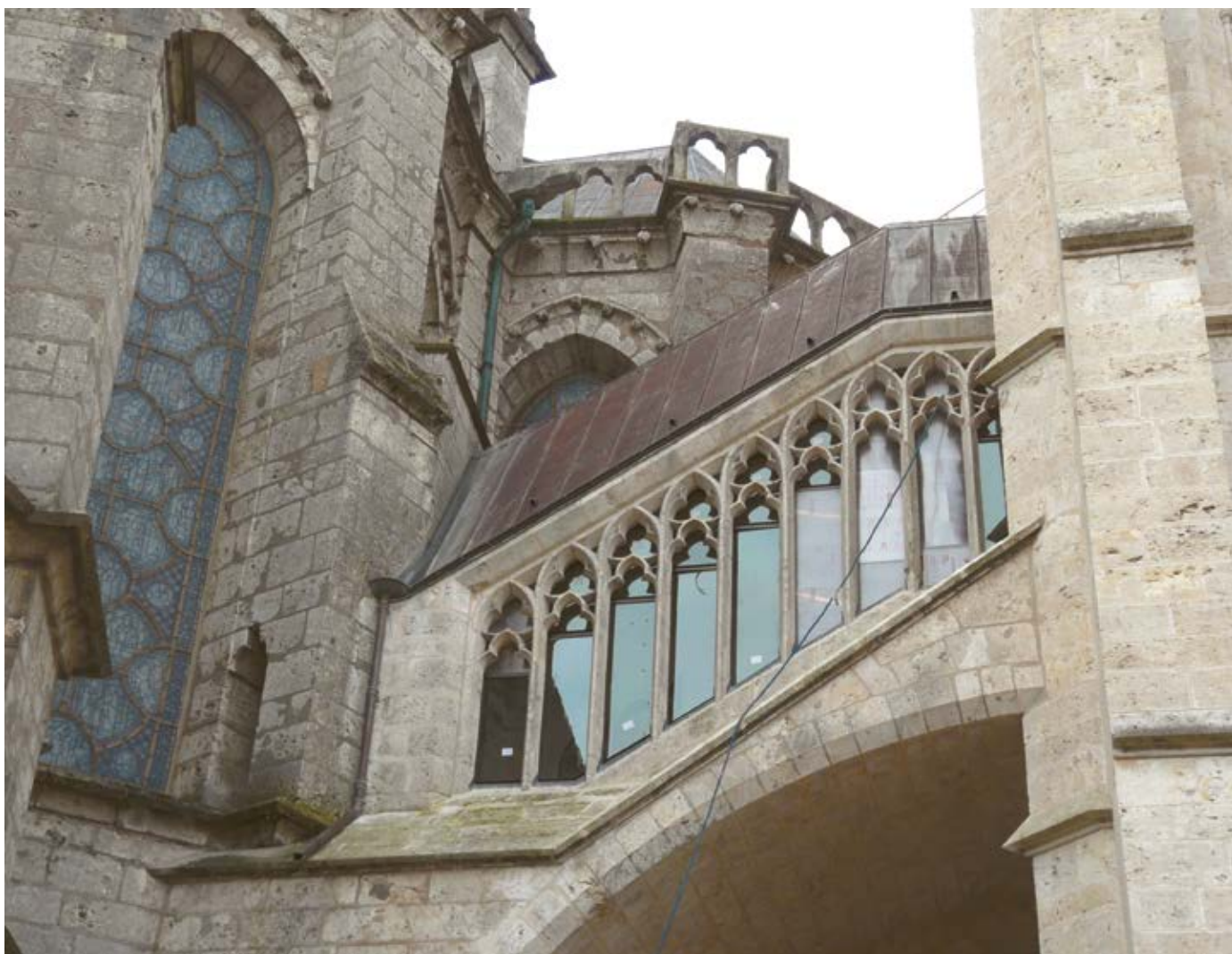
L'escalier reliant les deux édifices.
