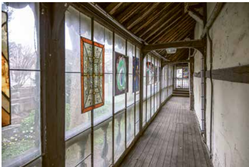
Site patrimonial historique de la Ville, les ateliers Lorin font l'objet de travaux de rénovation qui rendront au lieu son caractère exceptionnel.
