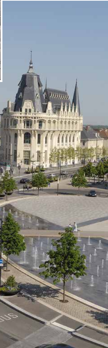
Vue de la place des Épars pendant et après les travaux: la construction du parking Cœur de ville a métamorphosé les abords du centre-ville.
