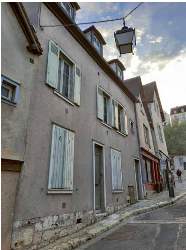
Les immeubles situés au 4, rue de la Volaille (ci-contre) et 6, rue du Bourg (ci-dessus) font l'objet d'un accompagnement facilitant leur rénovation.
