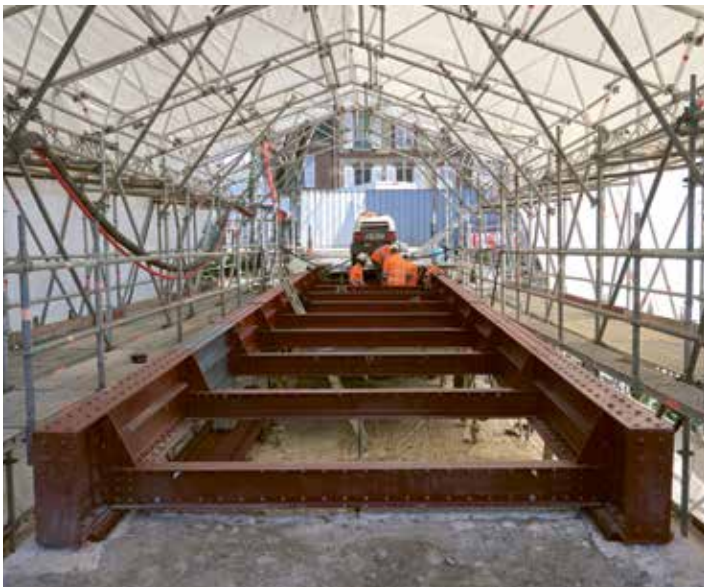
La technique du rivetage à chaud, notamment employée lors de la construction de la Tour Eiffel, est également utilisée dans le cadre de la rénovation de la passerelle des ateliers Lorin.
