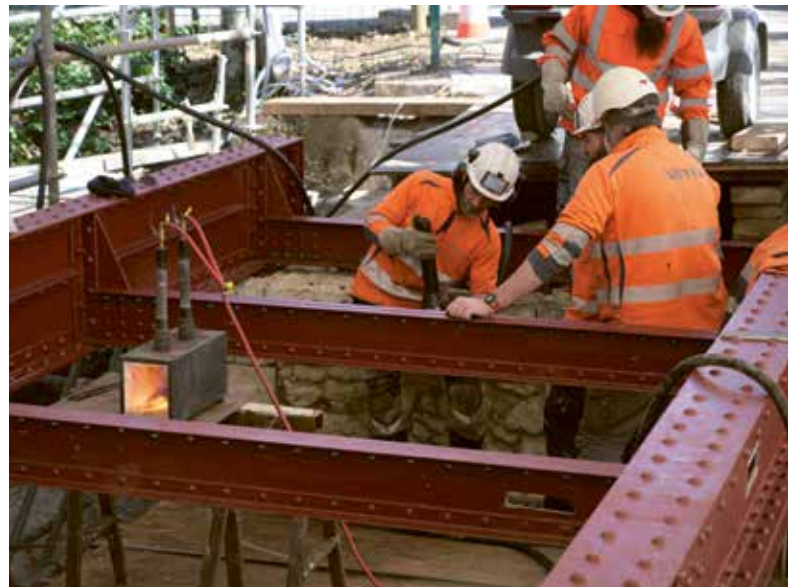
La technique du rivetage à chaud, notamment employée lors de la construction de la Tour Eiffel, est également utilisée dans le cadre de la rénovation de la passerelle des ateliers Lorin.
